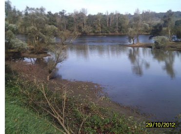
Vue générale après travaux
