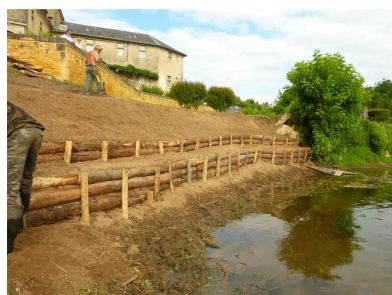
étape 1: conception du tunage et retalutage
