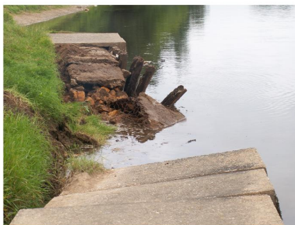
Siorac : quai fortement dégradé
