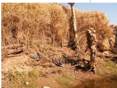
Beynac : état initial de l'érosion
